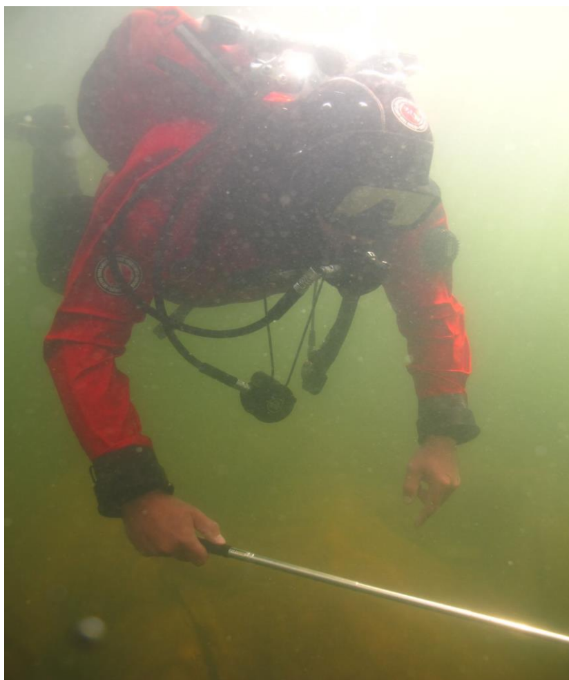
Fotografia 27. Nurek w trakcie prowadzenia kontroli rozłożenia mat (fot. P. Dynowski).
