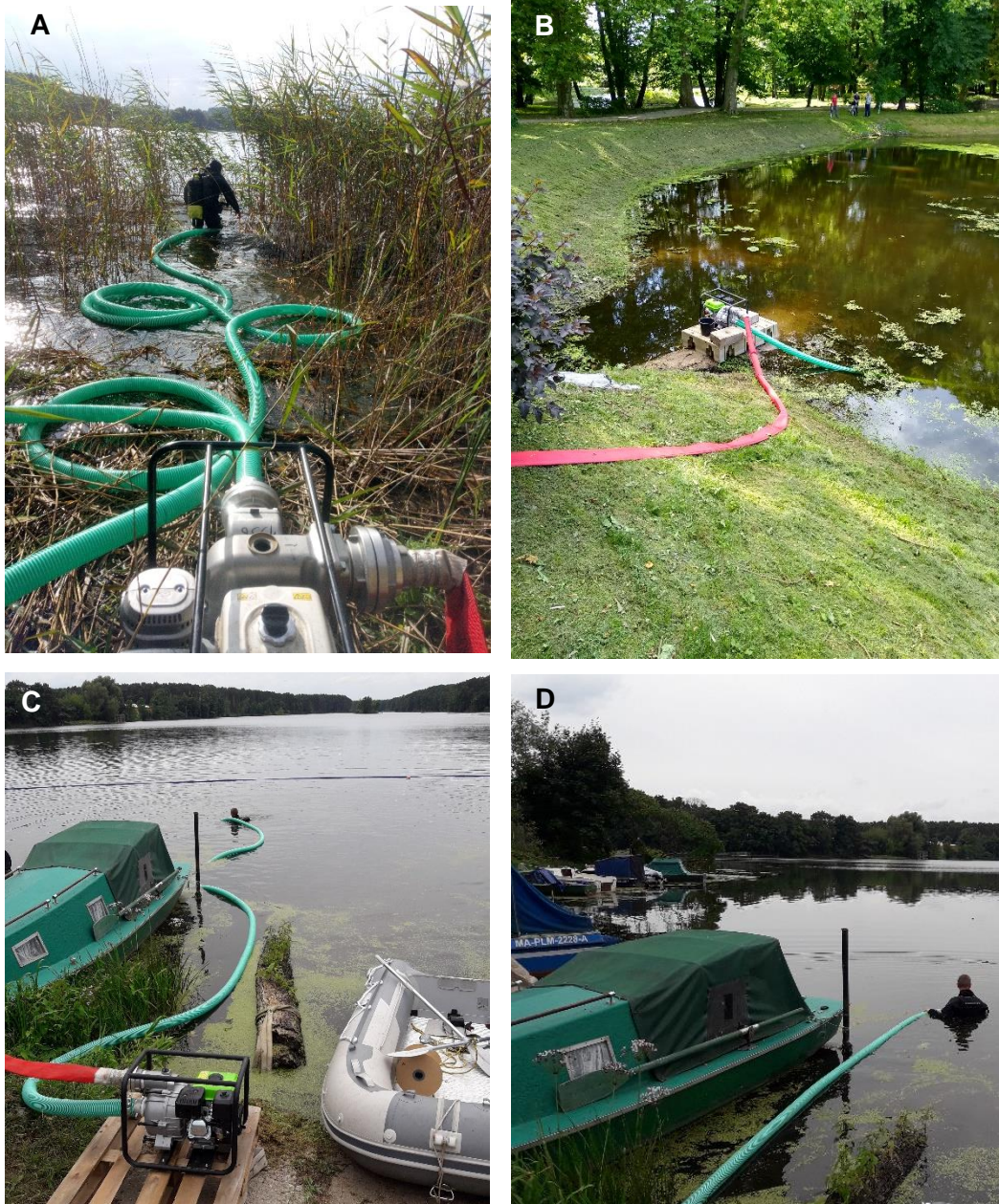
Fotografia 32A-D. Prowadzenie prac refulacyjnych z umiejscowieniem pompy ssawnej na brzegu (fot. A. – M. Draga, B-D. – Ł. Bryl).
