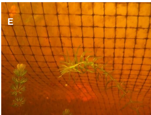
Fotografia 35A-F. Przygotowanie barier oddzielających, uniemożliwiających przedostanie się pływających fragmentów moczarki delikatnej z terenu prac zbiorników wodnych (fot. A-C. – R. Trafny, D. – Ł. Bryl, E-F. – M. Gąbka).
