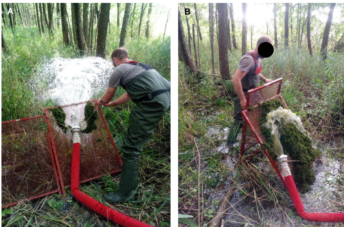
Fotografia 30A-B. Odbieranie urobku (masy roślinnej) po refulacji (fot. M. Draga).
