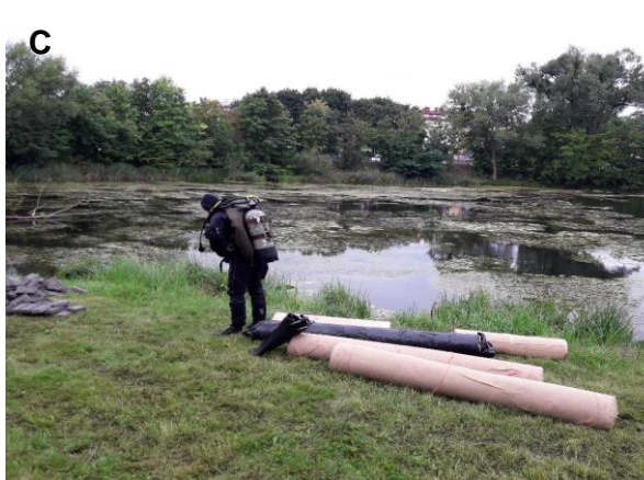
Fotografia 25A-D. Maty jutowe stosowane do zwalczania moczarki delikatnej, rozkładane przez nurków (fot. A-B. – M. Gąbka, C. – R. Trafny, D. – P. Dynowski).
